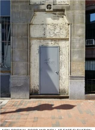
NON-ORIGINAL DOOR AND INFILL AT EAST ELEVATION
