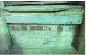
C. BRICK INFILL AT BASEMENT WINDOW
